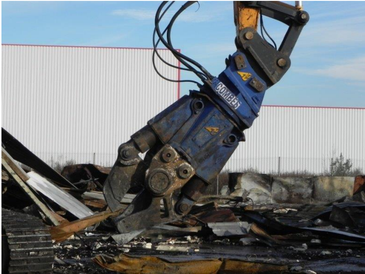
CU031 con mordaza CF para corte de chatarra con el mismo pico de loro que la conocida AS030
