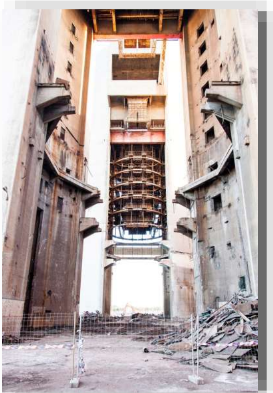
DESGUACE ASCENDENTE DE LAS CALDERAS
