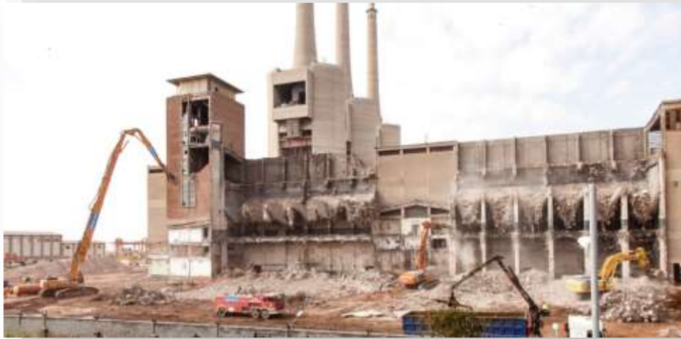
EDIFICIOS CON MÁQUINAS DE DEMOLICIÓN
