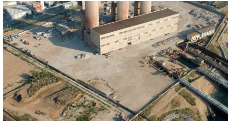
RELLENO Y NIVELADO
